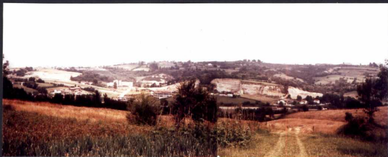
Foto 6.- Conjunto de explotaciones de arenas del Cretácico superior en las proximidades de Oviedo. En primer término de izquierda a derecha: 28-6, 28-12, 28-10 y 28-11 (activa). En segundo término, a nivel superior, de izquierda a derecha 28-15 y 28-14.
